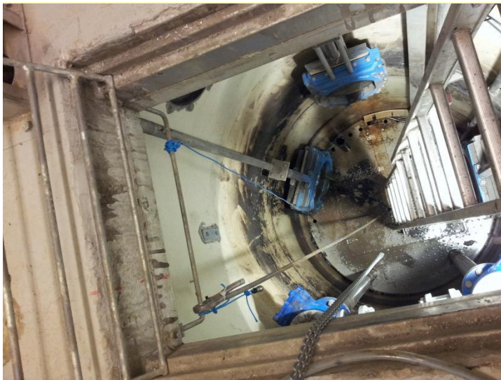
Figur 13: Fra pumpekum PAV. Overløpsrør til Stjørdalselva kan sees øverst til venstre i kummen (svart åpning)
