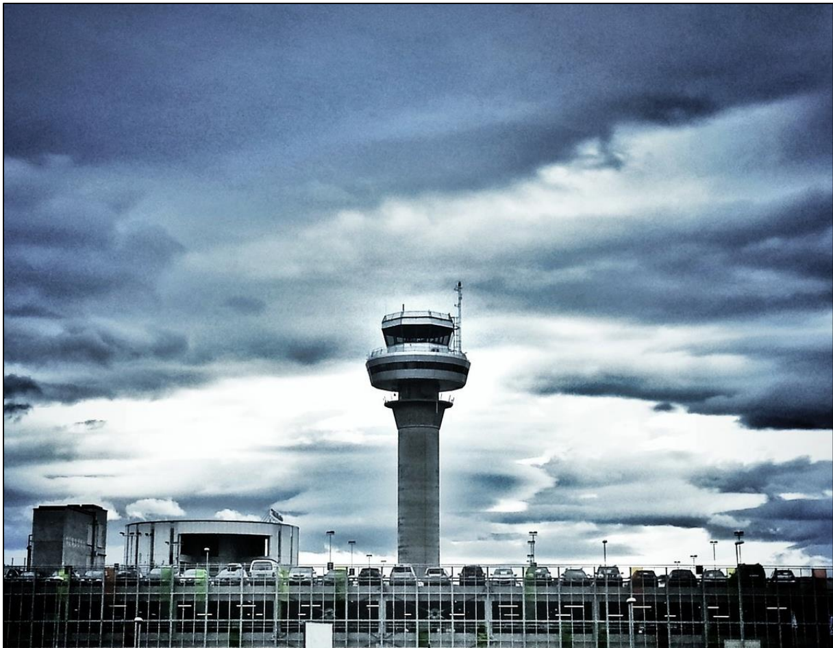
Figur 38. Tårnet ligger plassert ved siden av parkeringshuset P3. (Avinor, 2018) 19
