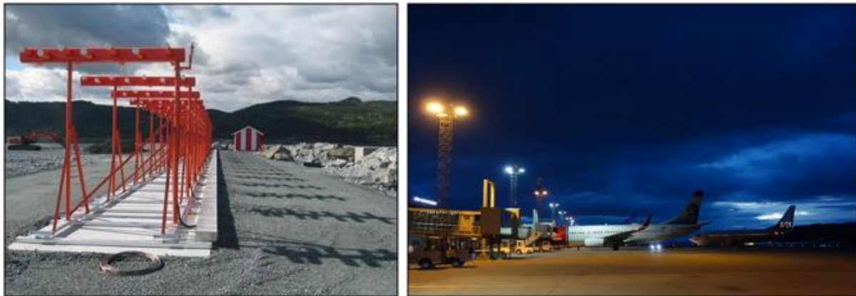
Figur 28. LOC i vestre baneende samt antenne og banebelysning foran terminal (Avinor, 2017) 14
