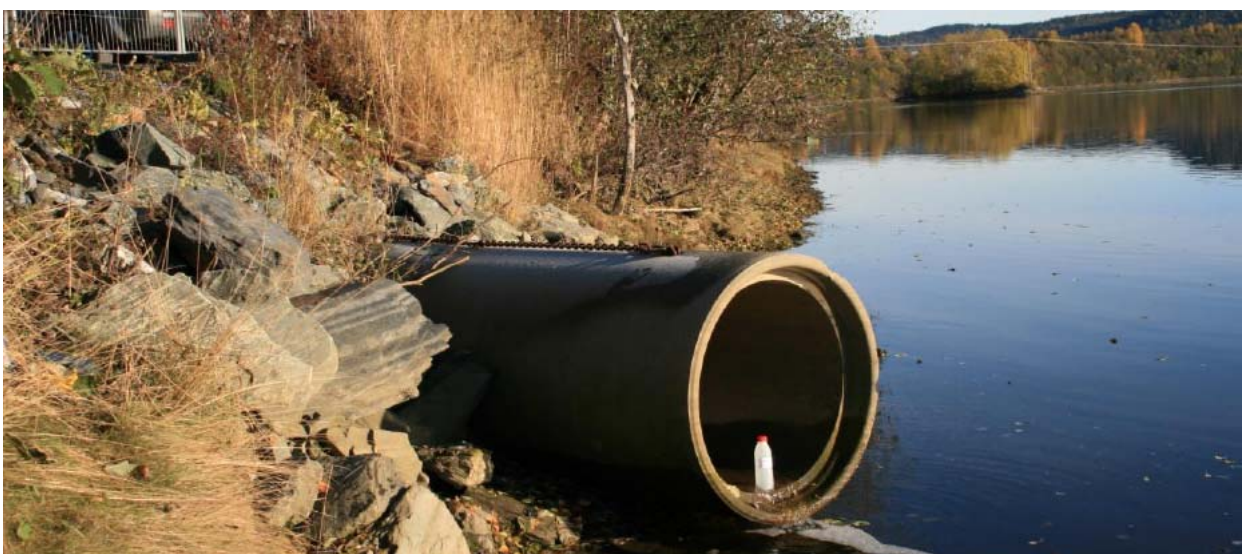
Figur 20. Viser utløpskulvert for åpen grøft hvor det har blitt tatt prøver av utløpsvannet (KUBR).
