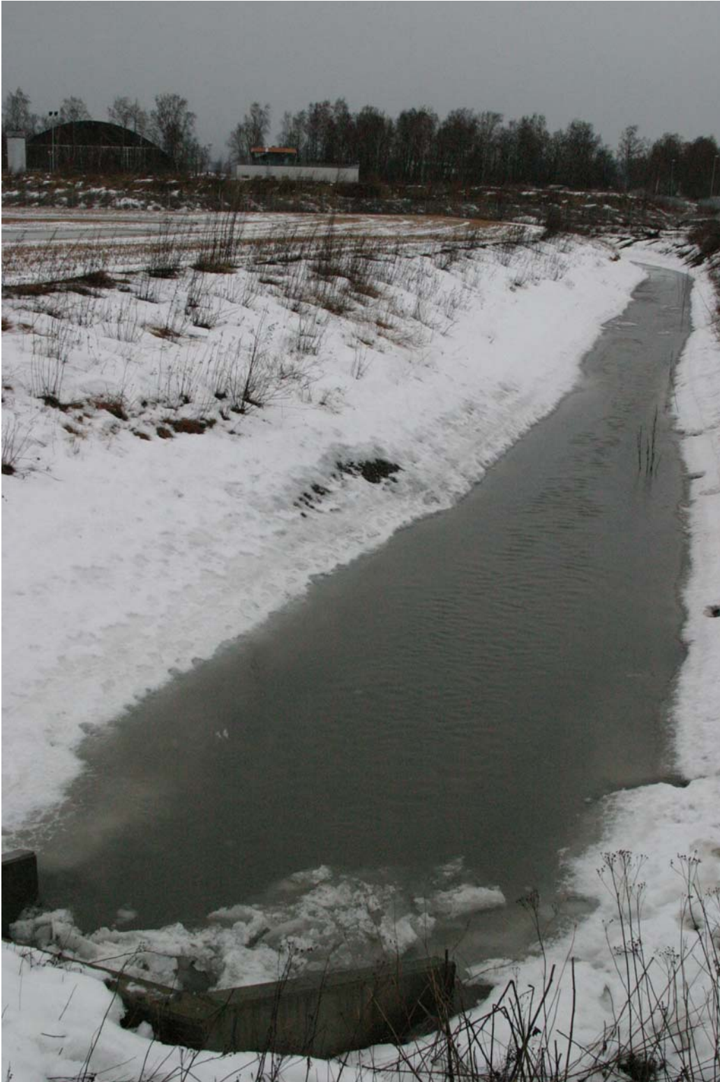
Figur 21. Viser åpen samlegrøft som drenerer grunnvann og overvann i områdene rundt og sør for brannøvingsområdet i en situasjon med stor avrenning 14.02.12.
