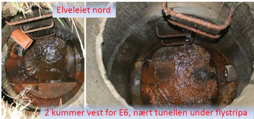
Figur 18. Viser OV1 og OV2 som er inspeksjonskummer for mindre overvanns- og dreneringssystemer langs E6 og flyplassen.
