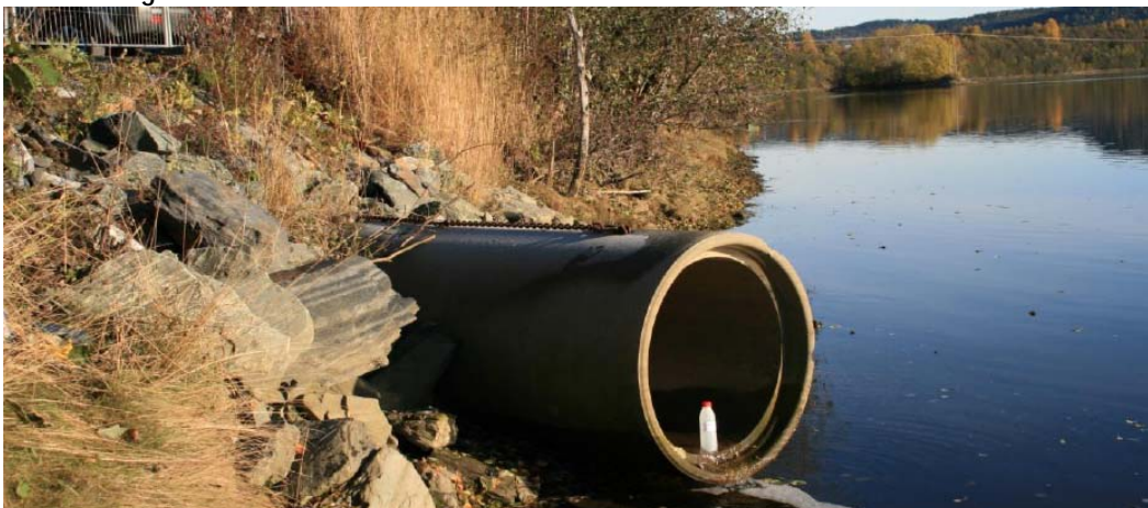
Figur 18. Viser utløpskulvert for åpen grøft hvor det har blitt tatt prøver av utløpsvannet (KUBR).
