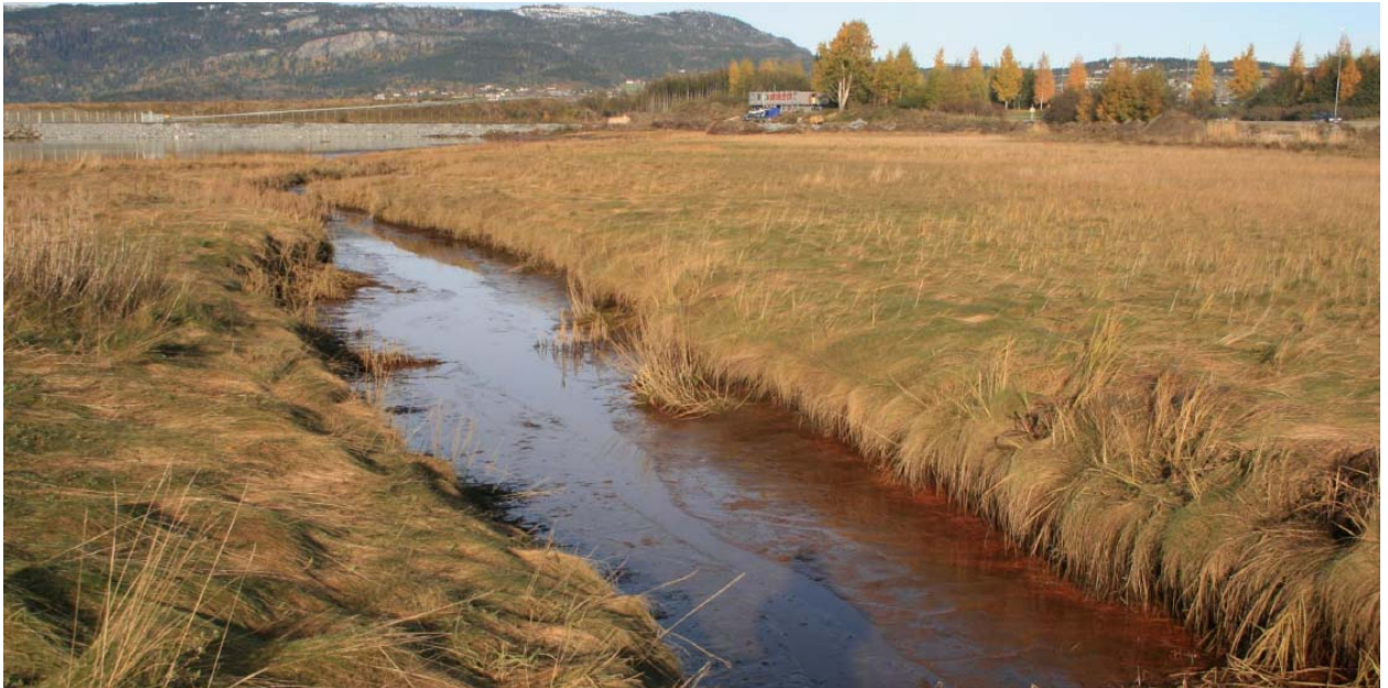
Figur 19. Viser åpen kanal (GRØS) med utløp til den sørlige delen av det gamle elveleiet i oktober 2009.
