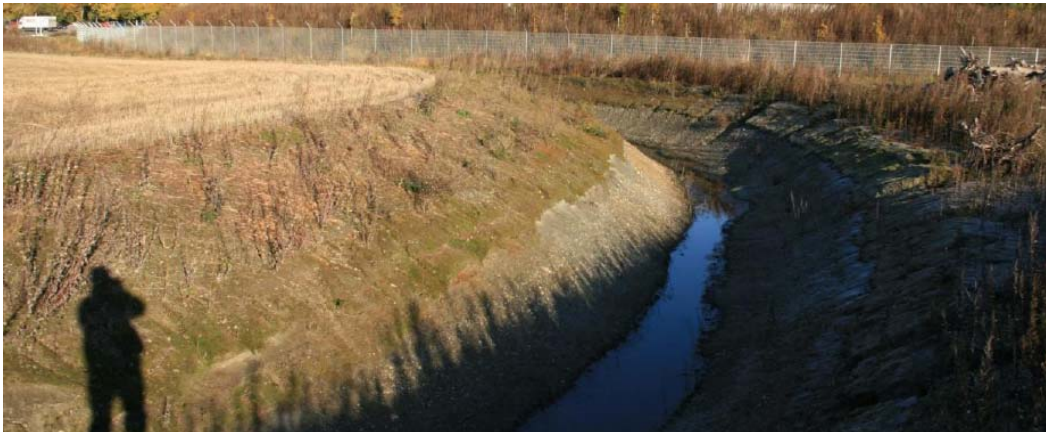
Figur 17. Viser åpen samlegrøft som drenerer grunnvann og overvann i områdene rundt og sør for brannøvingsområdet.
