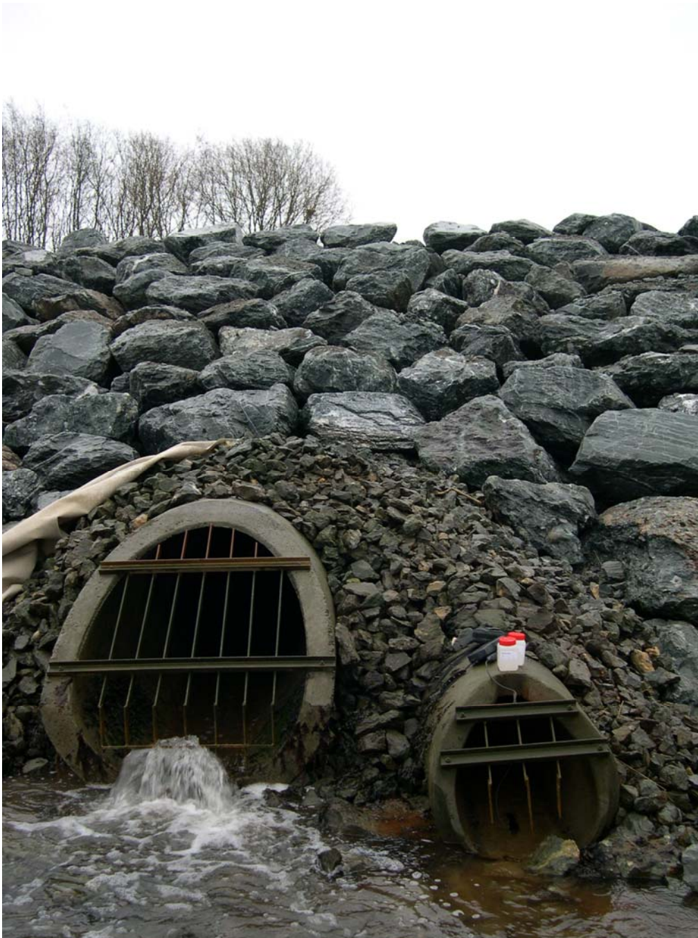
Figur 21. Viser stor (SRGE) og liten (LGE) kulvert etter at disse har blitt forlenget ut i det gamle elveleiet som en del av byggeprosessen for ny E6 i området.
