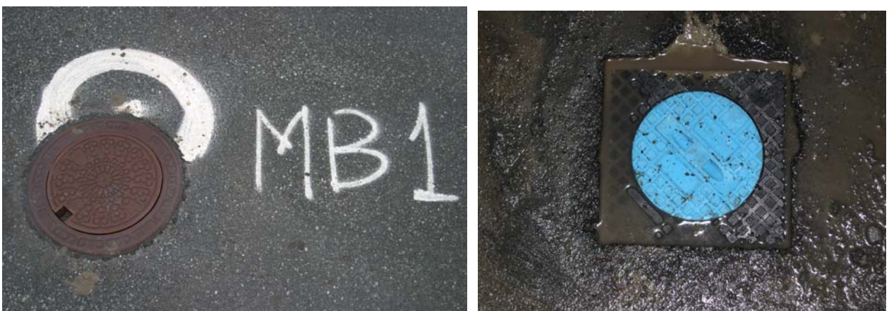
Figur 4. Miljøbrønnene MB1 og MB2 ligger inne på flyoppstilling og har kjørbart lokk. Miljøbrønn MB3 ligger langs lokalveg nedstrøms deicing og har en annen type lokk.
