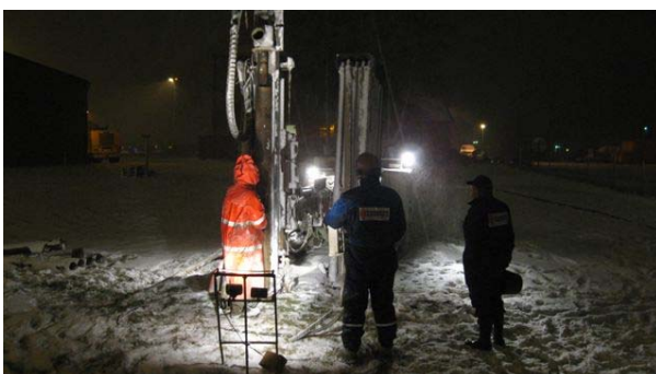
Figur 4. Nedsetting av grunnvannsbrønner ved deicing (A) og rullebane (B) medio januar 2007.
