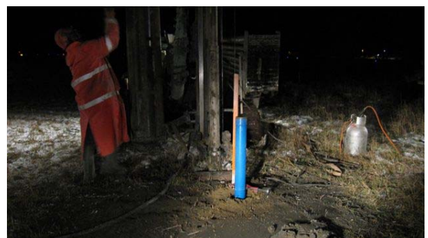
Figur 4. Nedsetting av grunnvannsbrønner ved deicing (A) og rullebane (B) medio januar 2007.
