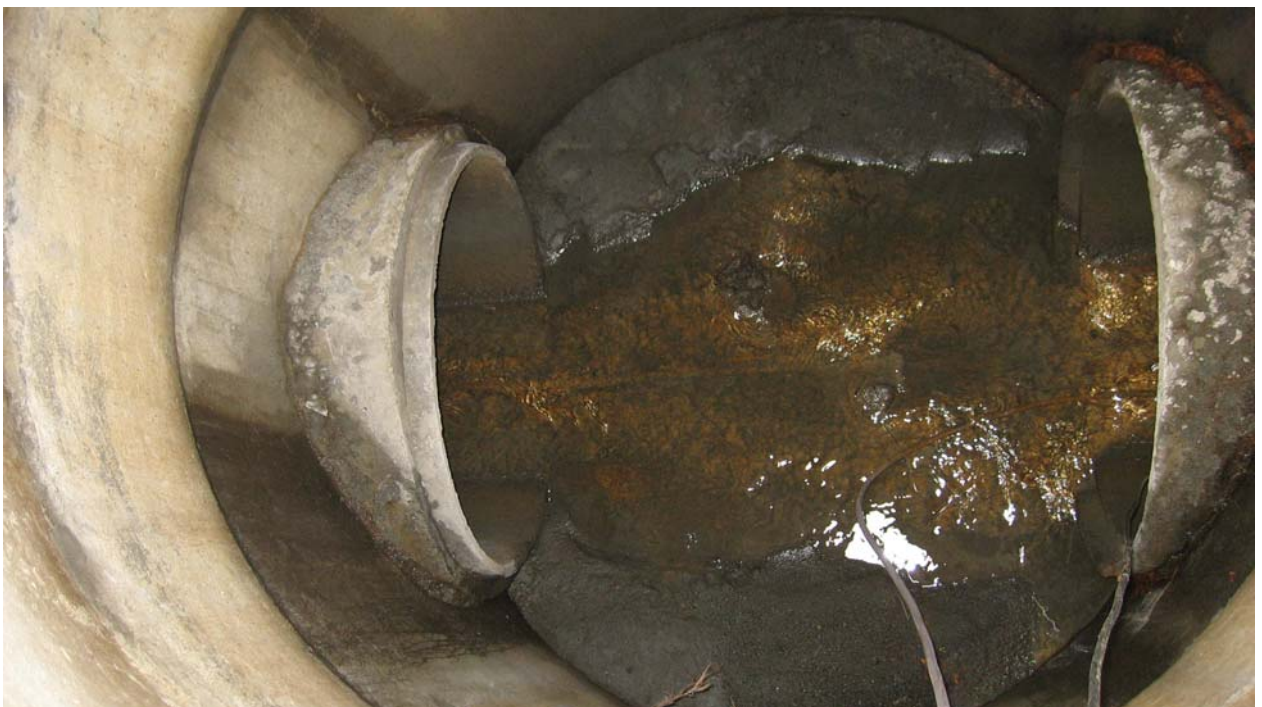
Figur 1. Fra kum i stor overvannskulvert hvor det har blitt gjennomført kontinuerlig måling av vannføring og uttak av blandprøver gjennom avisings sesongen 06/07 (foto: K. E. Flataker).
