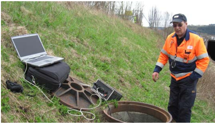
Figur 2. Fra feltbesøk med innhenting av data og vannprøver fra utstyr montert i inspeksjonskum for stor overvannskulvert mot det gamle elveleiet (foto: K. E. Flataker).
