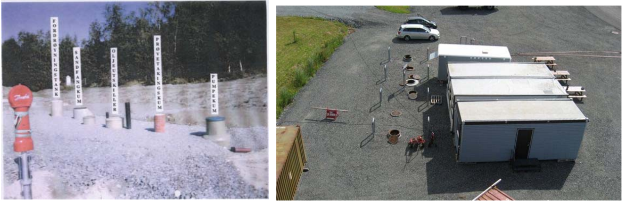
Figur 16. Fotografier som viser inspeksjons- og prøvetakingskummer i renseløsning.
