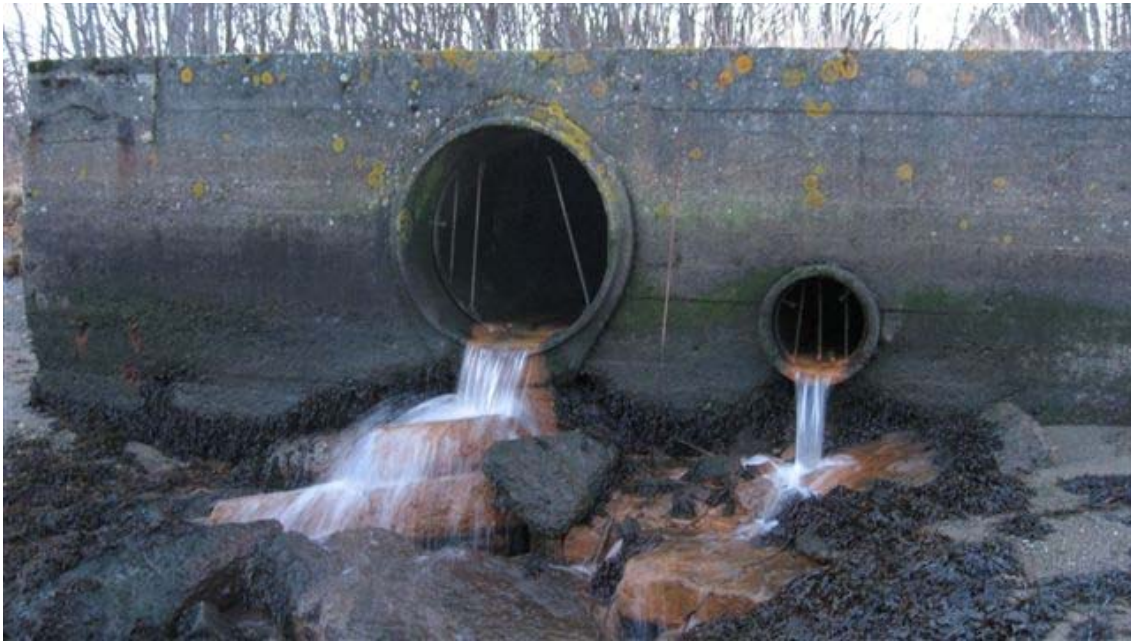
Figur 3. Stor og liten kulvert som fører overvann til utslipp i det gamle elveleiet. Det har blitt tatt manuelle vannprøver med to ukers intervaller gjennom hele sesongen 06/07 (foto: K. E. Flataker).
