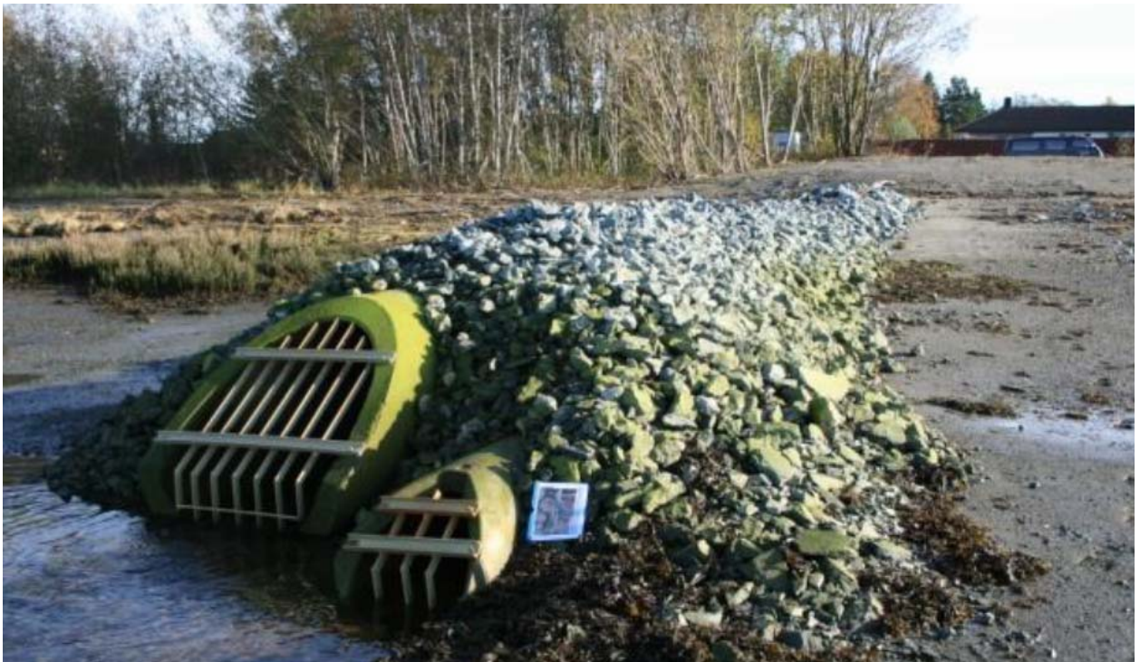
Figur 17. Viser stor (SRGE) og liten (LGE) kulvert etter at disse har blitt forlenget ut i det gamle elveleiet som en del av byggeprosessen for ny E6 i området.
