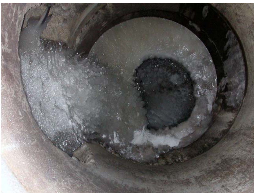
Figur 9. Viser ising i inspeksjonskum for overvann i januar 2010 (12.01.10)
