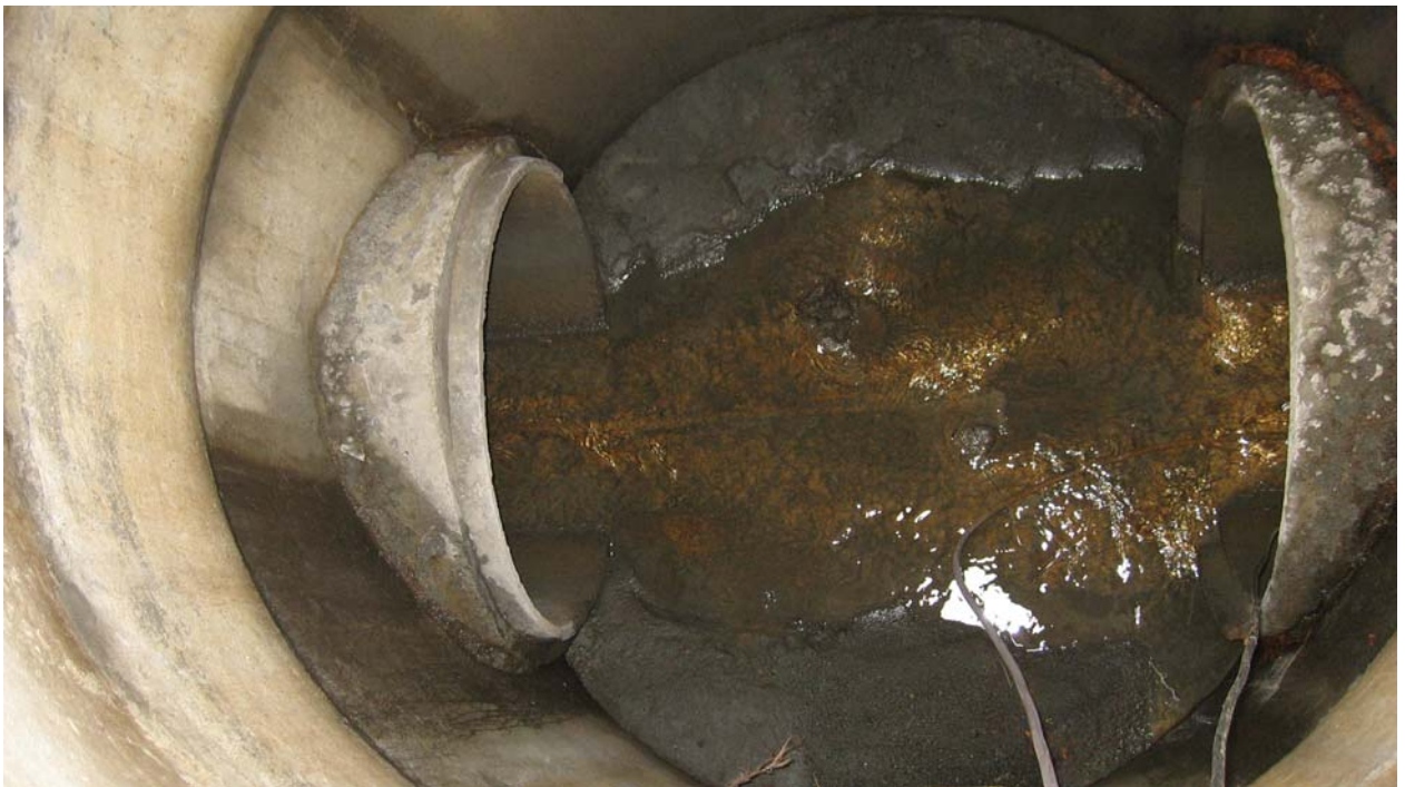
Figur 1. Fra kum i stor overvannskulvert hvor det har blitt gjennomført kontinuerlig måling av vannføring og uttak av blandprøver gjennom avisingssesongene 06/07, 07/08 og 08/09 (foto: K. E. Flataker).
