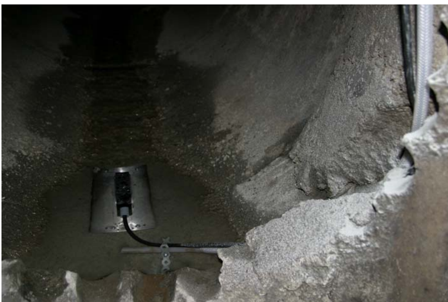
Figur 9. Viser areal-hastighet sonde for måling av vannføring og sugeslange for uttak av blandprøve i overvannssystem med utslipp til Stjørdalselva.
