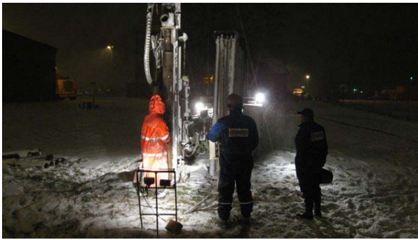
Figur 5. Nedsetting av grunnvannsbrønner ved deicing (A) og rullebane (B) medio januar 2007.
