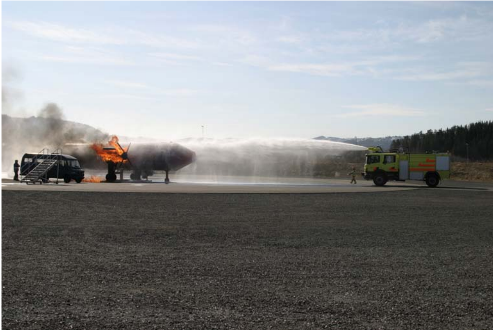
Figur 14. Viser brannøvingsområdet på Trondheim lufthavn under øvelse sesongen 07/08. Overskuddsvæske har fall til dreneringsrenne i senter av området og føres til behandling i renseanlegg før utslipp.
