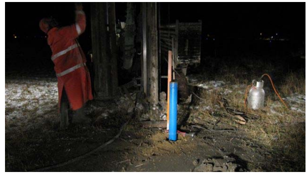
Figur 5. Nedsetting av grunnvannsbrønner ved deicing (A) og rullebane (B) medio januar 2007.
