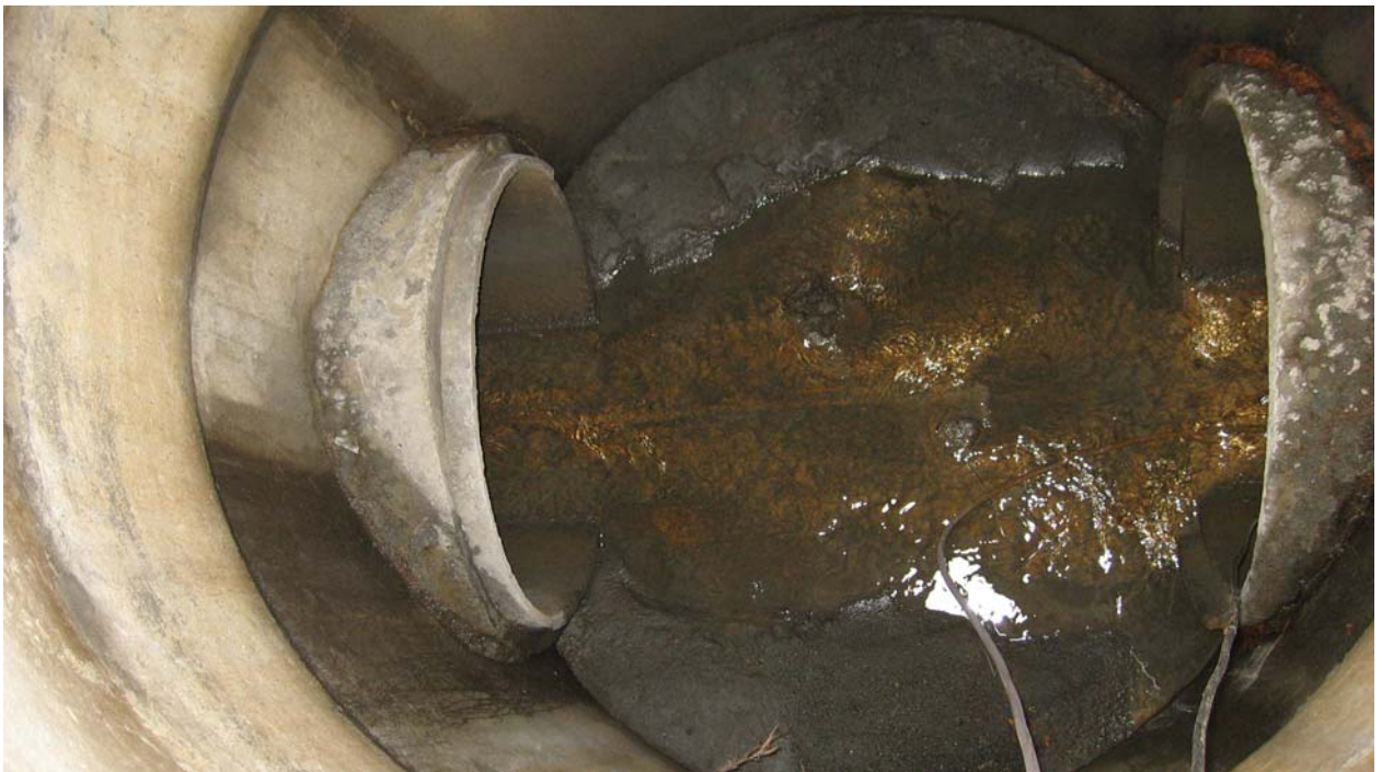
Figur 1. Fra kum i stor overvannskulvert hvor det har blitt gjennomført kontinuerlig måling av vannføring og uttak av blandprøver gjennom avisings sesongene 06/07 og 07/08 (foto: K. E. Flataker).
