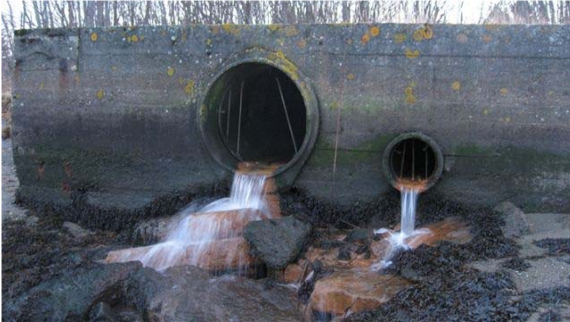
Figur 4. Stor og liten kulvert som fører overvann til utslipp i det gamle elveleiet. Det har blitt tatt manuelle vannprøver månedlig gjennom sesongen 07/08 (foto: K. E. Flataker).
