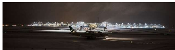
Planlagt for utskifting til LED-belysning.
